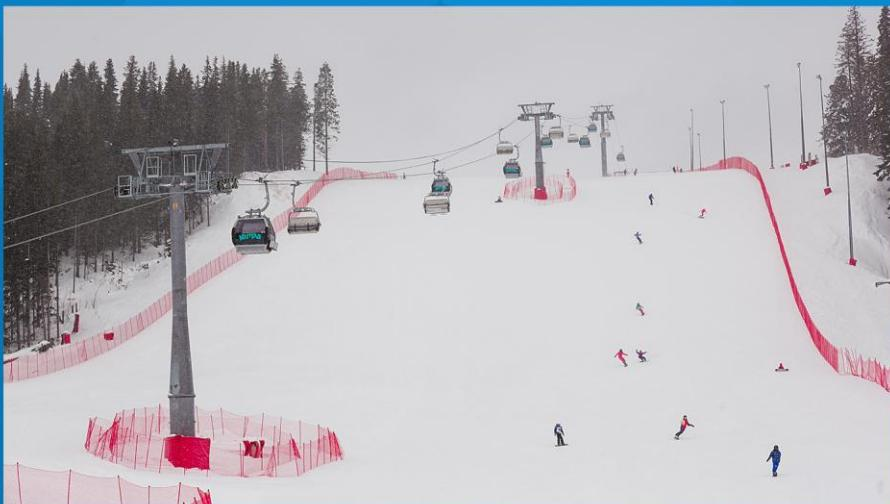
Пассажирская кресельная канатная дорога протяженностью 984 м, чья пропускная способность 2 000 человек в час. Время в пути в одну сторону приблизительно 5 минут. Горнолыжная трасса имеет протяженность 433 м и перепад высот 120 м с системой искусственного оснежения, 3 промежуточные станции, трассы для параллельных дисциплин (сноуборд).
